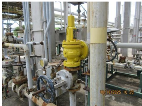
ภาพที่ 2.1-6 วาล์วนิรภัย (Safety Relief Valve)
