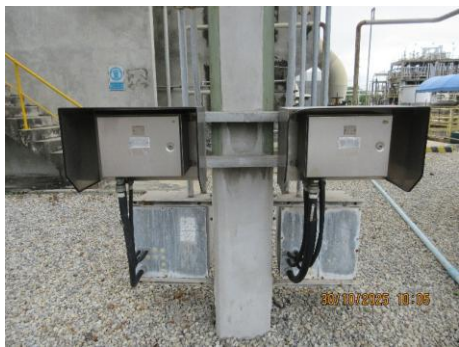
ภาพที่ 2.1-36 ตู้ Panel แบบป้องกันการเกิดประกายไฟ
