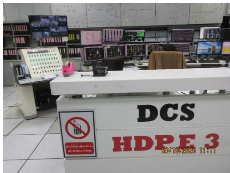
ภาพที่ 2.1-32 Distributed Control System (DCS)
